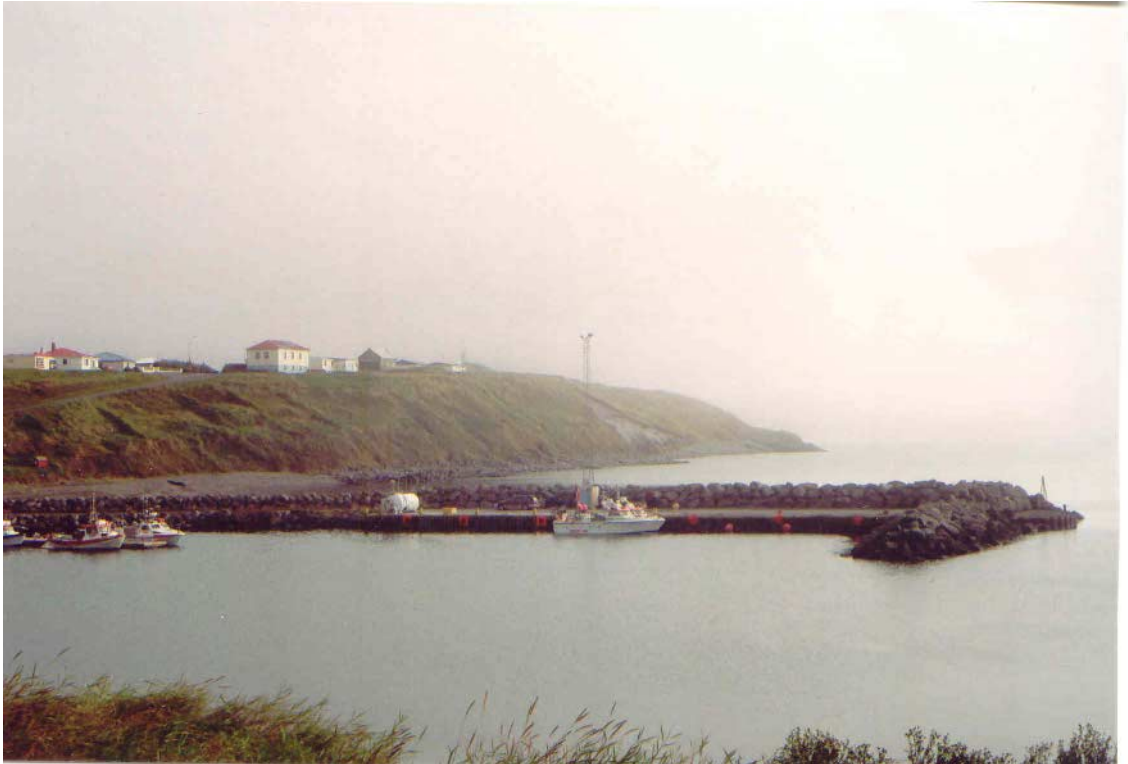
1. mynd. Sjávarbakkinn á Hofsósi var kannaður vegna hugsanlegrar hrun- og skriðuhættu. Í þokunni sést glitta í örið sem nýlega hefur rofist í gróðurþekjuna utan á bakkanum. (Ljósmynd Halldór G. Pétursson 2006).
