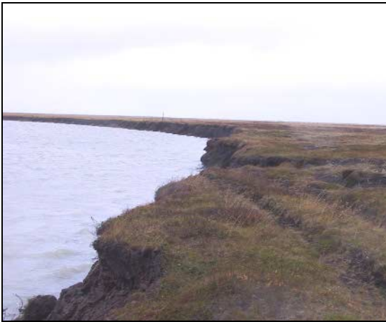
18. ljósmynd a. Landbrot við austurbakka Lagarfljóts gegnt Grænanesi, horft til norð-austurs. Ljós. SHM 6. 10. 2004.
