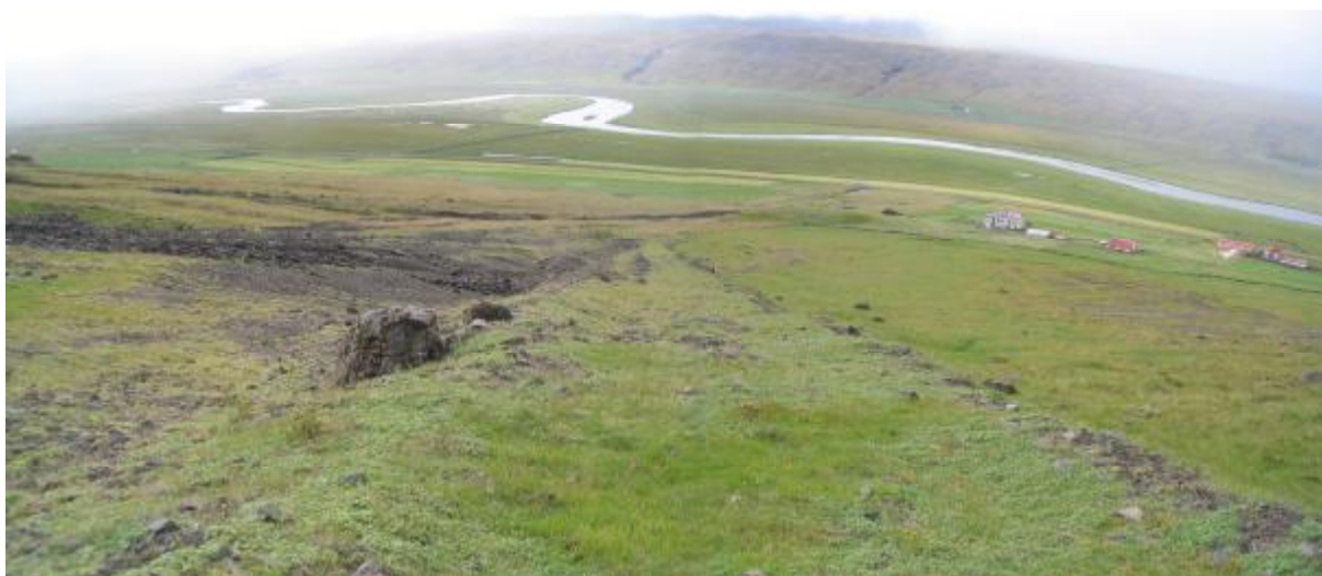
Mynd 2: Horft niður aurkeiluna eftir varnargarði 2. Farvegur 2 stefnir beint á garðinn sem beinir honum síðan niður keiluna. Bæjar- og útihús á Hvammi sjást hægra megin á myndinni (Ljósmynd: Höskuldur Búi Jónsson 2005).
